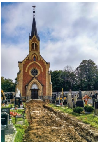
Stavební práce na hřbitově
