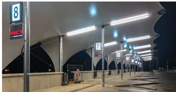
Zastřešení peronu působí lehce a vzdušně, oblouky evokují podloubí na náměstí.
