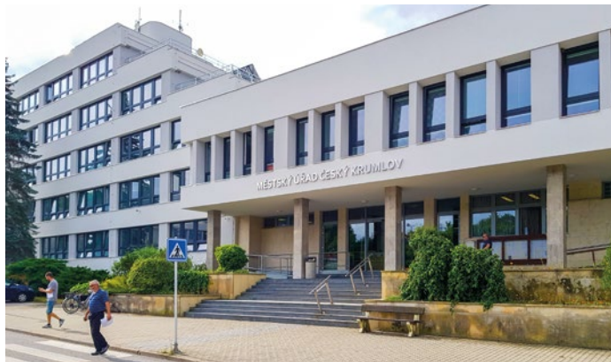
Zrekonstruovaná budova městského úřadu v Kaplické ulici.
