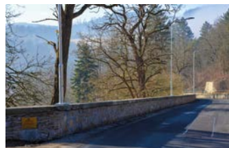
Opěrná zeď na třídě Míru
